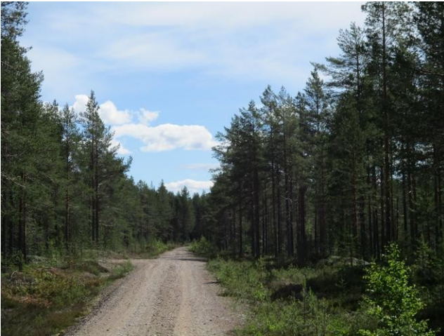
Kuva 43. Tie voimalapaikalle T29. Kuvattu itään.
