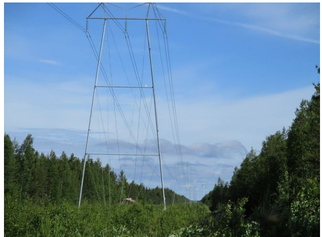
Kuva 18. Läntinen voimalinja Muhojoen kohdalla kuvattu pohjoiseen.
