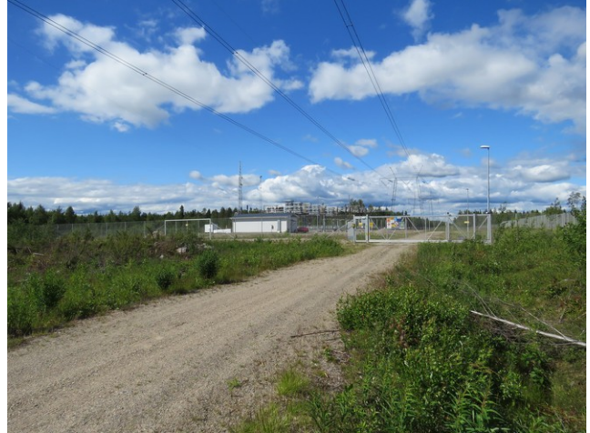
Kuva 64. Raatokankaan sähköasema kuvattu pohjoiseen.
